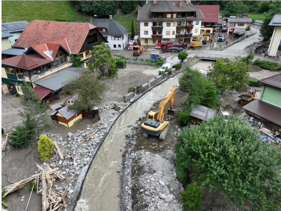
Abbildung 103: Hochwasserschäden des Feldbaches in Innerkrem. Zu sehen sind Geschiebe-, Sediment- und Totholzablagerungen im linken und rechten Vorland; Quelle: viewcopter.at
