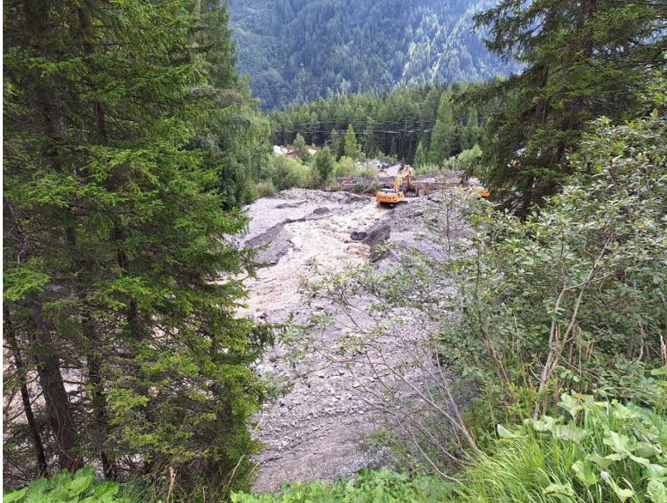
Abbildung 125: hm 9,90-11,00: Becken 2 „Steissbach“ ca. 35.000m 3 Feststoffablagerungen; Quelle: die.wildbach
