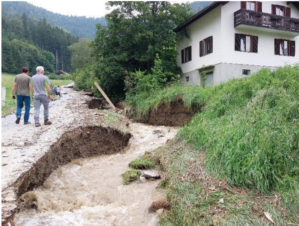
Abbildung 33: Tiefenerosion bei hm 3,5 (09.06.2024) © WL.V.
