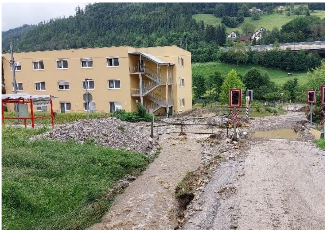
Abbildung 34: Überschotterter Gleiskörper, hm 0,0 (09.06.2024) © WL.V.
