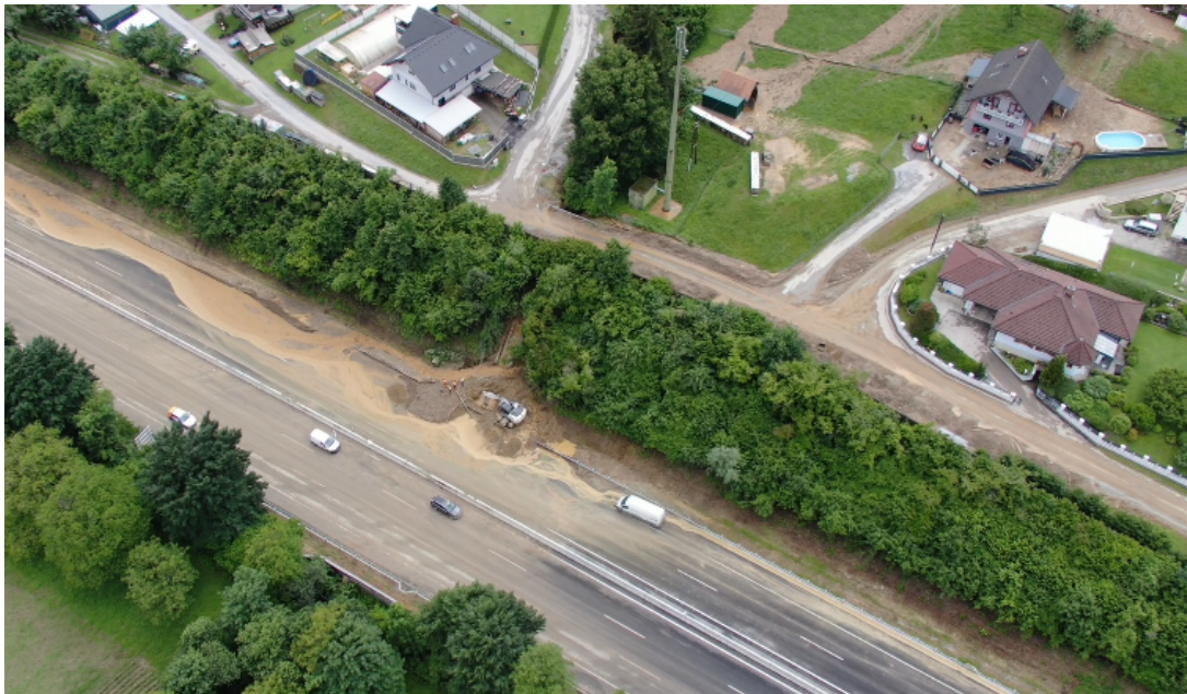
Abbildung 42: Murstoß auf Phyrn Autobahn, hm 2,0 (09.06.2024) © WLV.
