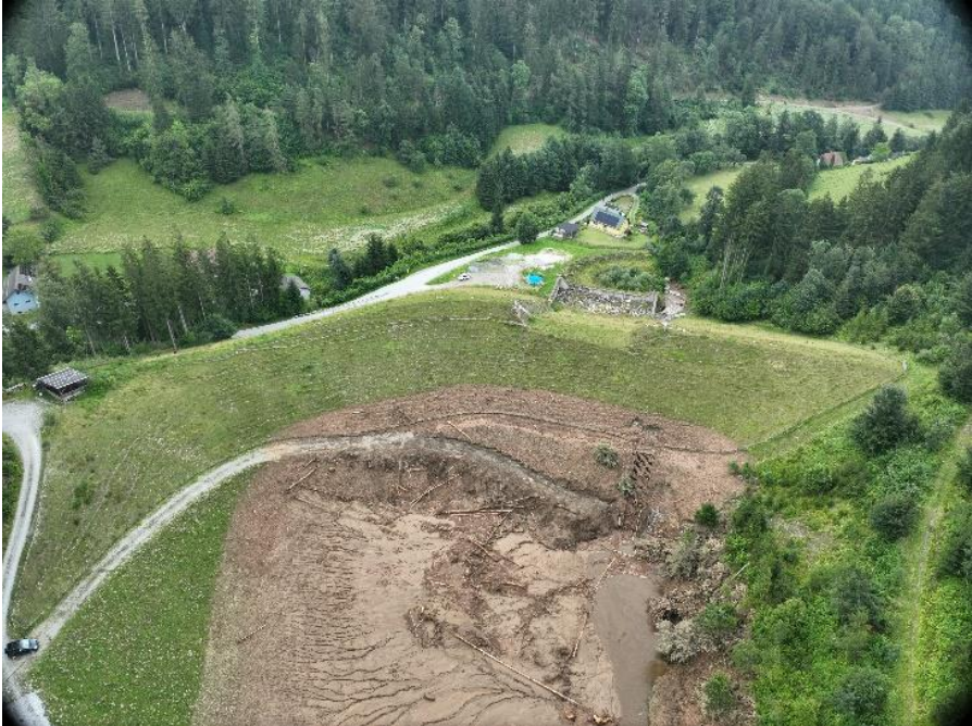
Abbildung 73: Rückhaltebecken Lankowitzbach (12.07.2024), Quelle: die.wildbach
