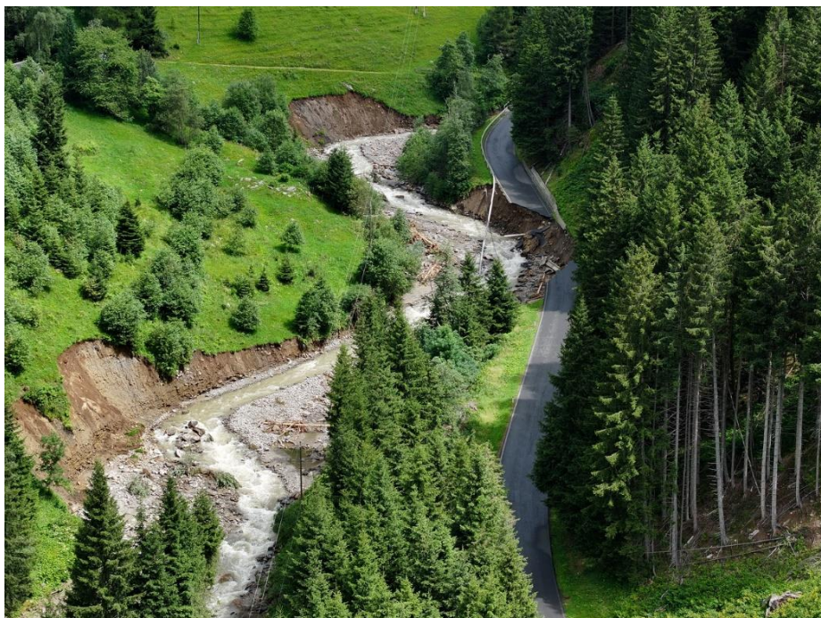
Abbildung 104: Hochwasserschäden des Feldbaches bei Innerkrem. Die L19 Innerkremser Landesstraße wurde an dieser Stelle zerstört; Quelle. viewcopter.at
