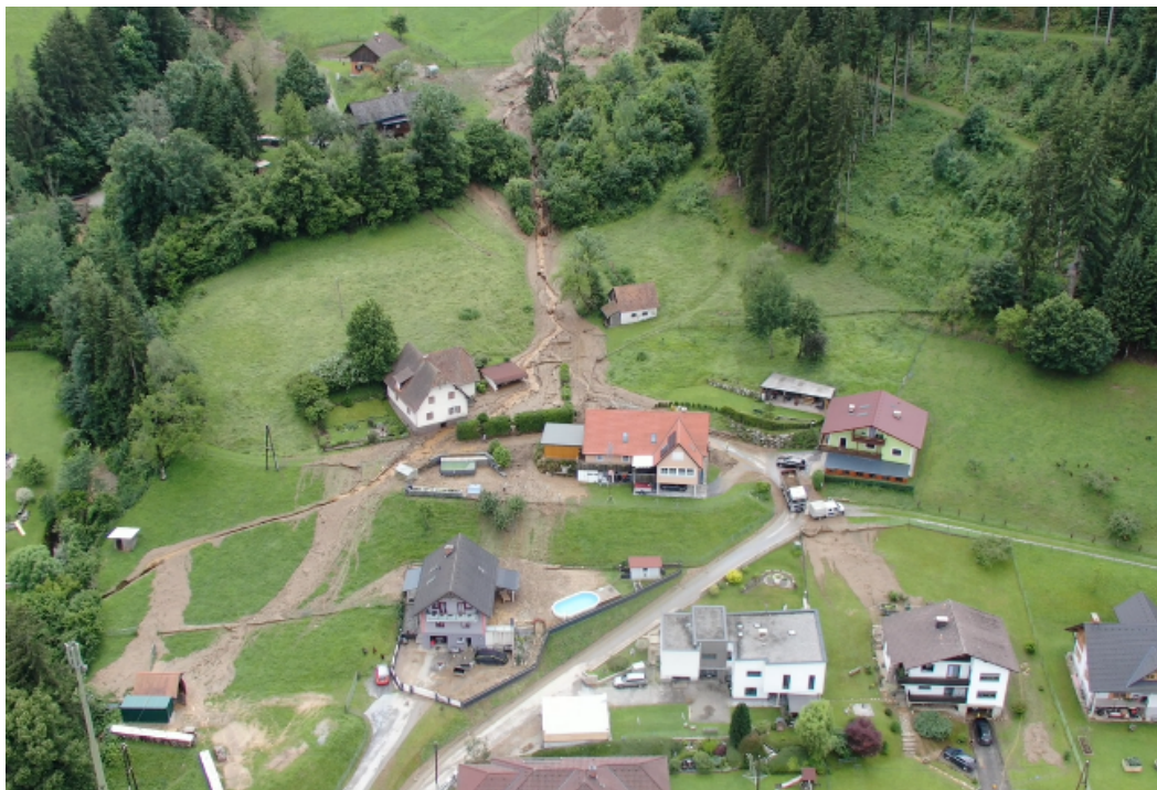
Abbildung 41: Murstoß im Siedlungsraum Kleiner Wartbach hm 3,0 (09.06.2024) © WLV.
