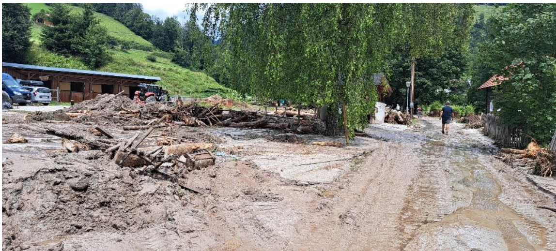
Abbildung 89: Ablagerungen von Wildholz Geschiebe, hm 40,0 (17.07.2024), Quelle: die.wildbach
