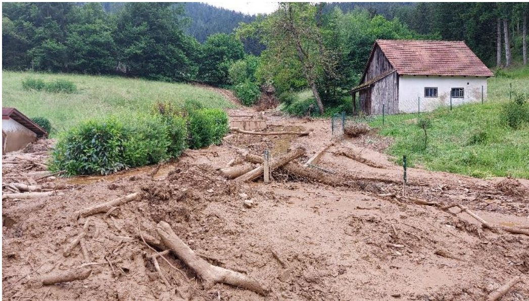
Abbildung 38: Murstoß am Grabenausgang Kleiner Wartbach hm 1,0 (09.06.2024) © WLV.
