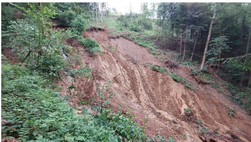
Abbildung 37: Rutschfläche Wartbach hm 8,0 (09.06.2024) © WL.V.
