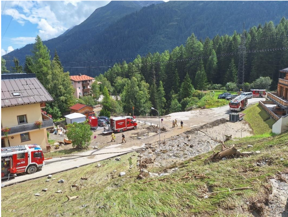
Abbildung 123: hm 9,80: Überflutete und überschotterte Flächen unterhalb vom 2. Becken; Quelle: die.wildbach
