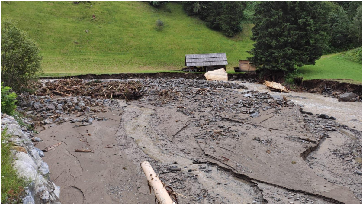
Abbildung 105: Hochwasserschäden des Feldbaches in InnerkremS (Geschiebe- und Sedimentablagerungen); Quelle: die.wildbach
