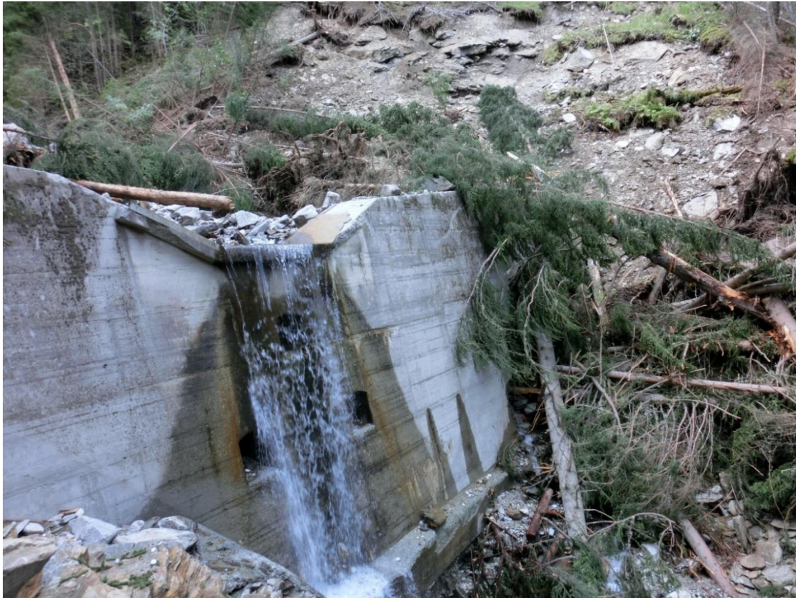
Abbildung 109: Sediment, Stein- und Totholzablagerungen an einer Geschiebesperre des Schulterbaches; Quelle: die.wildbach
