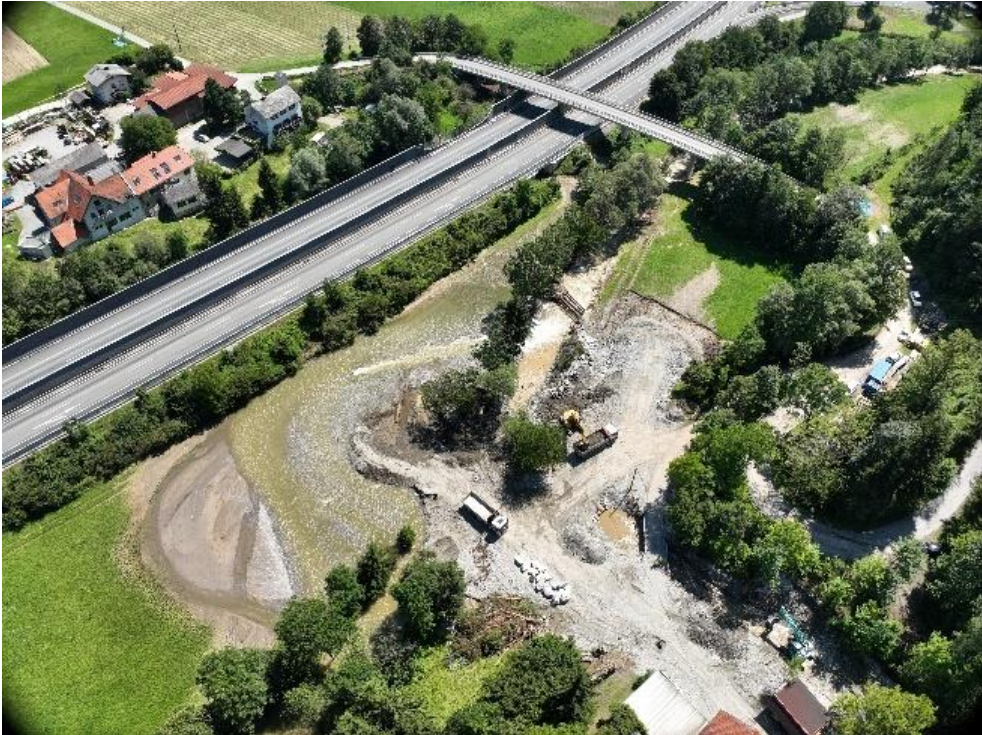
Abbildung 50: Einstoß Feisterbach und Verwerfung Übelbach (18.06.2024) © WLV.
