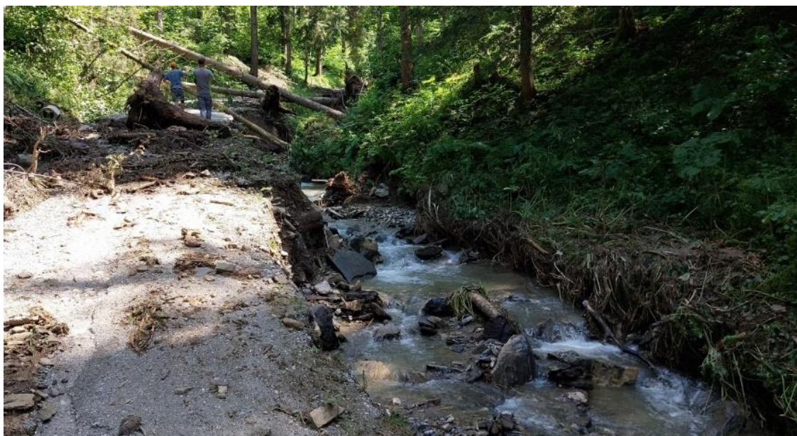
Abbildung 45: Tiefenerosion auf Hofzufahrt, hm 9,2 (09.06.2024) © WL.V.
