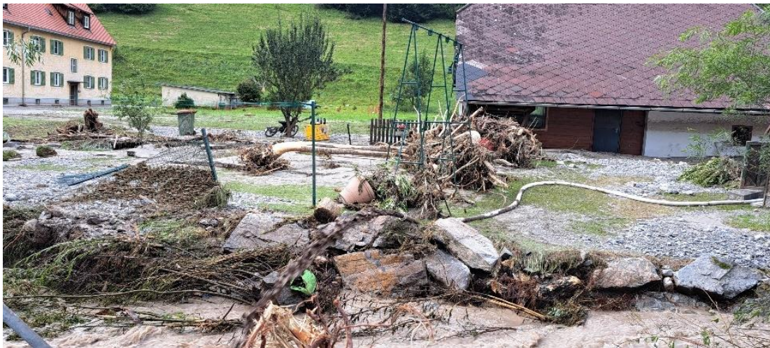
Abbildung 95: Geschiebe- und Wildholzablagerung rechtsufrig bei hm 9,0 (17.07.2024), Quelle: die.wildbach
