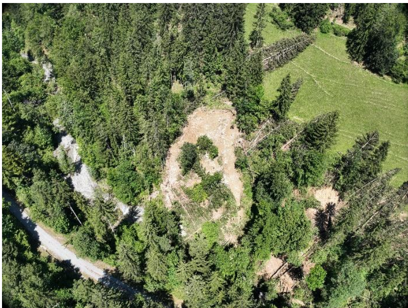
Abbildung 47: Große Einrutschung in den Bachlauf (18.06.2024) © WL.V.
