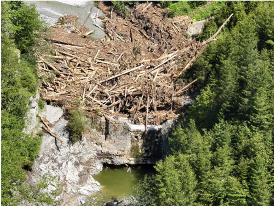
Abbildung 97: Mit Wildholz und Geschiebe beaufschlagte Sperre, hm 73,5 (19.07.2024), Quelle: die.wildbach
