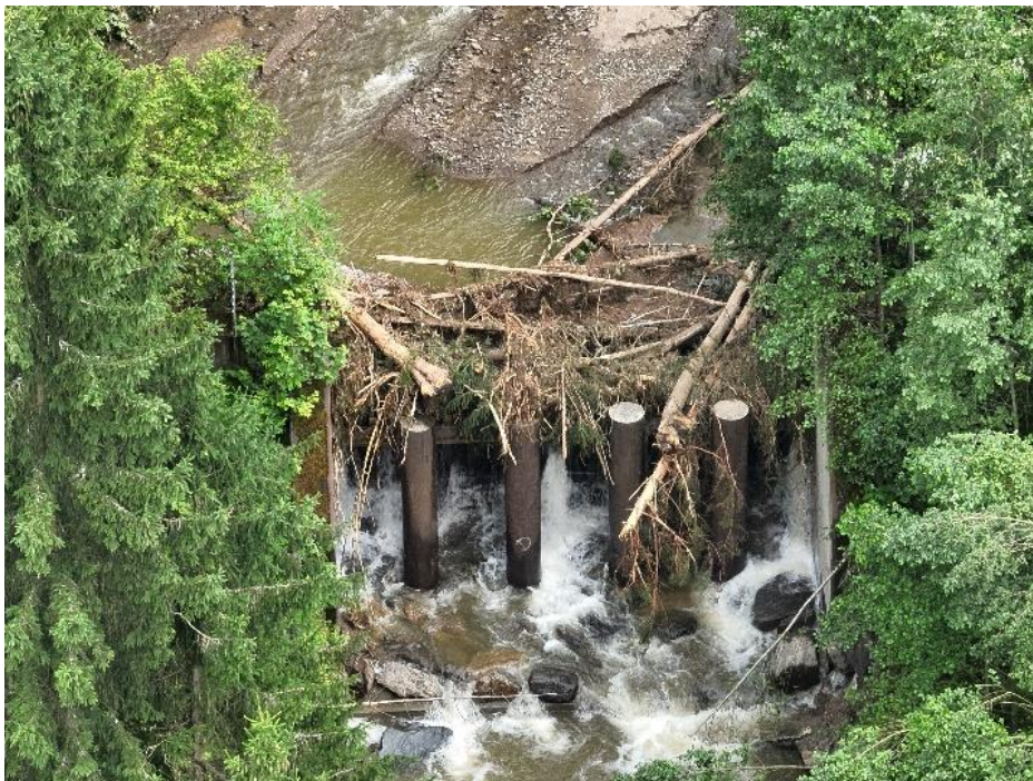
Abbildung 75: Rechen vor Rückhaltebecken Lankowitzbach (12.07.2024), Quelle: die.wildbach
