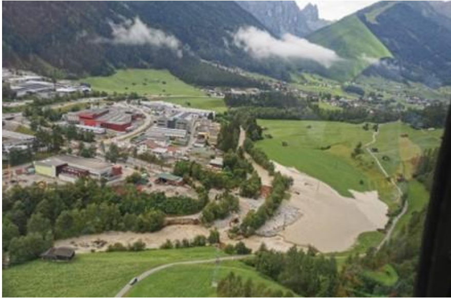
Abbildung 27: Überflutete Flächen im Mündungsbereich auf Grund des Rückstaus der Ruetz
