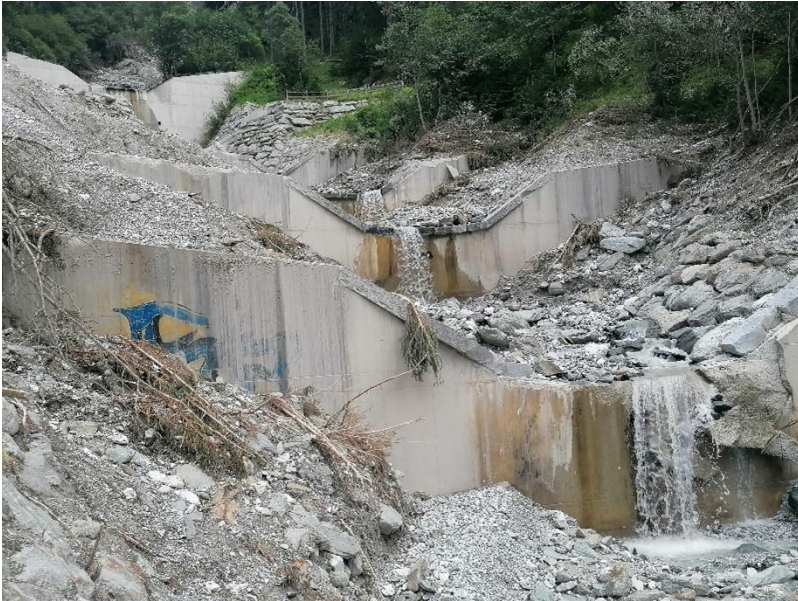
Abbildung 23: Sperrenstaffelung nach Ereignis in Blick Richtung bachaufwärts
