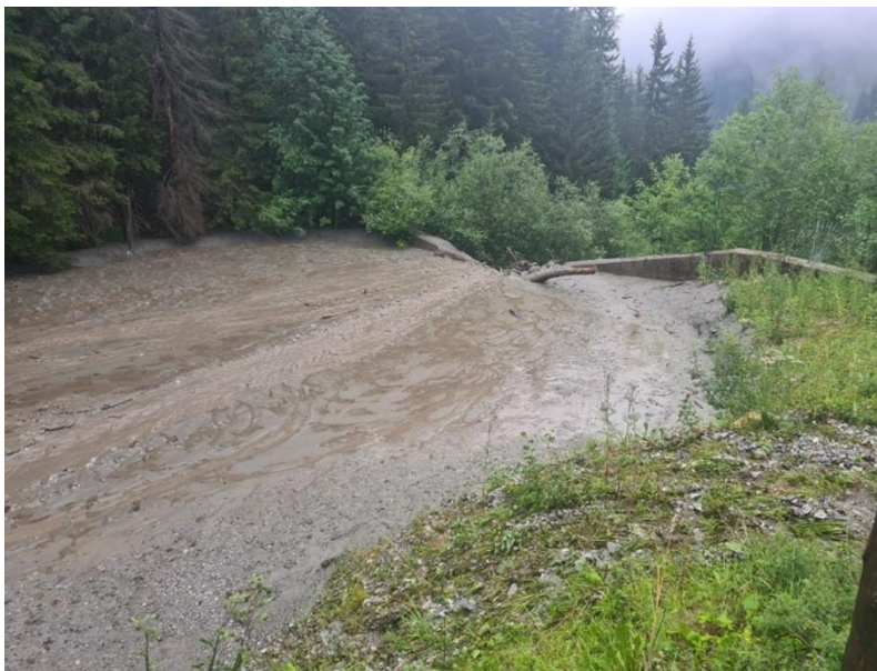
Abbildung 45: Sortierwerk voll gefüllt
