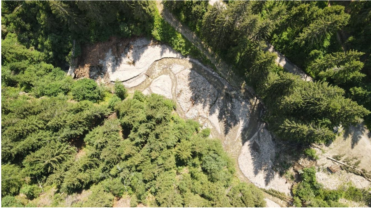
Abbildung 54: Verfüllter Verlandungsraum der Geschiebesperre am Einachbach, Gde. Stadl-Predlitz
