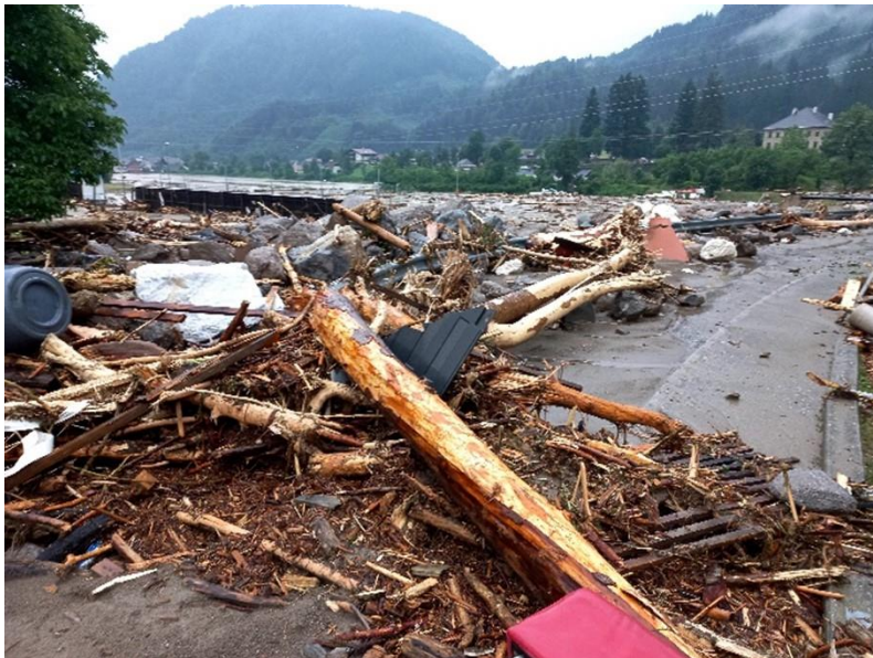
Abbildung 64: hm2,0; Geschiebeablagerung im Bereich der Unterlaufkünette – im Hintergrund Sportplatz und Vorflut (Blickrichtung bachabwärts)
