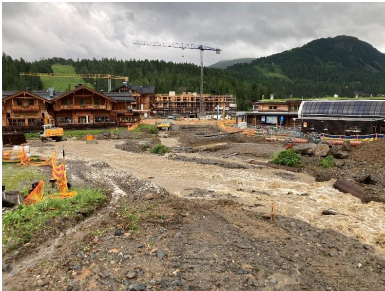
Abbildung 53: Kornockbach – Hochwasserbeaufschlagung des im Bau befindlichen Verbauungsprojektes der Wildbach- und Lawinenverbauung
