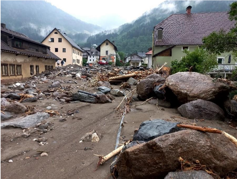
Abbildung 65: hm 2,0; Geschiebeablagerungen im Bereich der Unterlaufkünette – im Hintergrund Landesstraßenbrücke (Blickrichtung bachaufwärts)
