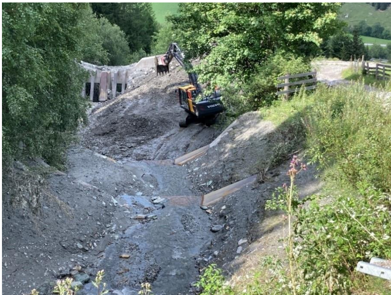
Abbildung 47: Kurvenüberhöhung zwischen Murbrecher und Filterbauwerk – mit Konsolidierungswerken gesichert.
