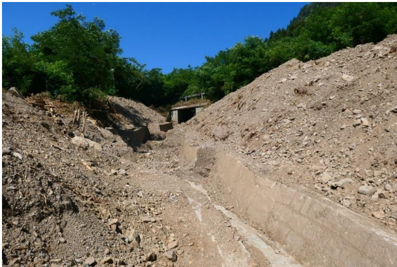
Abbildung 61: Geräumte Unterlaufverbauung
