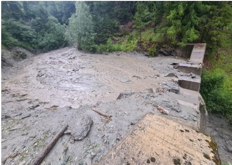
Abbildung 44: Blick zum gänzlich hinterfüllten Murbrecher
