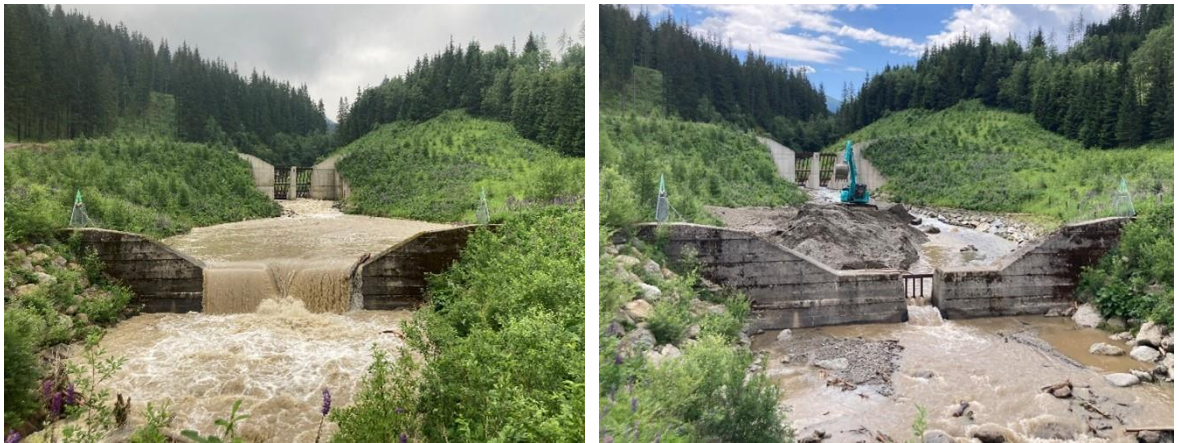
Abbildung 55: Geißbeckbach während des Ereignisses und bei den Räumungsarbeiten der Geschiebeanlandungen
