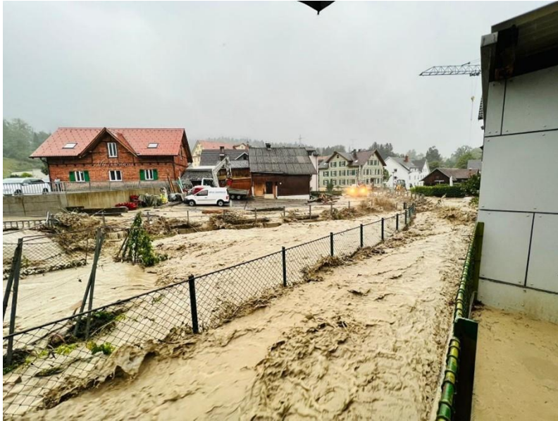
Abbildung 86: Überflutungen am St. Wendelinsbach in Kennelbach
