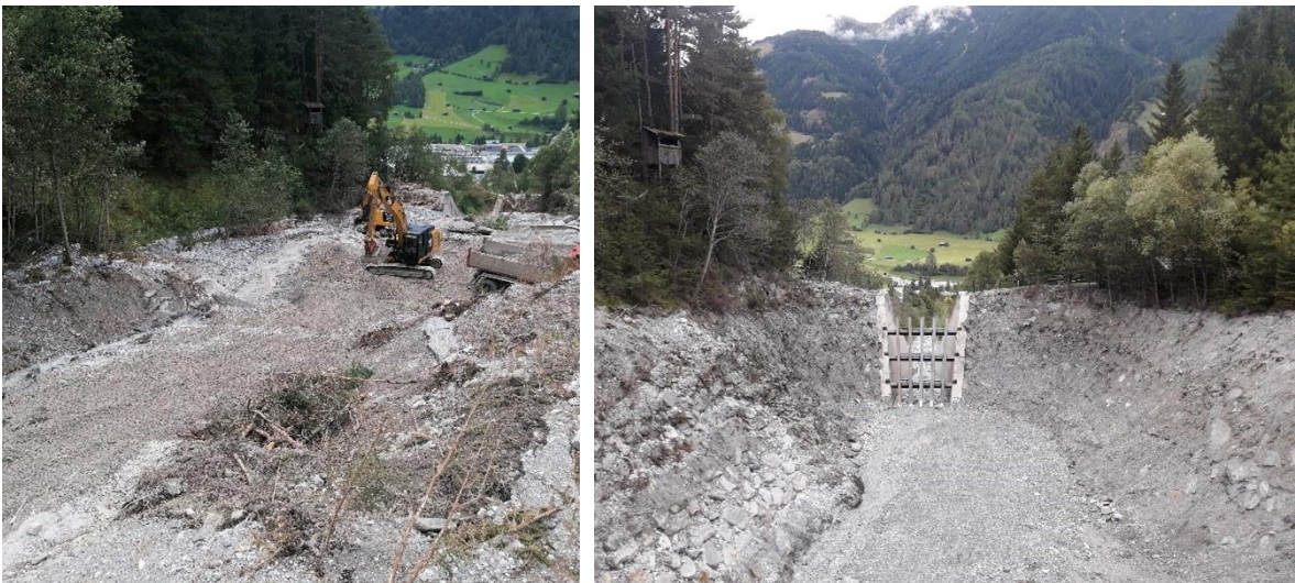
Abbildung 24: Geschiebeablagungsbecken im Zuge der Räumungsarbeiten (links) und das Geschiebeablagungsbecken nach fertiggestellter Räumung (rechts)
