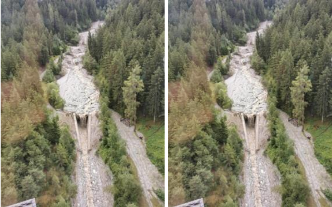
Abbildung 21: Geschiebeablagerungsbecken und Sperrstaffelung nach dem Ereignis
