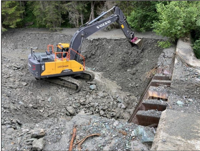
Abbildung 46: Filterbauwerk – Räumung Filterteil
