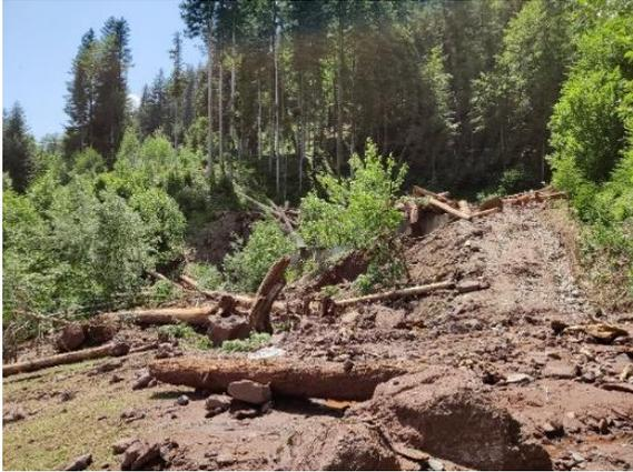
Abbildung 50: Foto 1 - Überströmte Sperre, freigelegter linker Flügel
