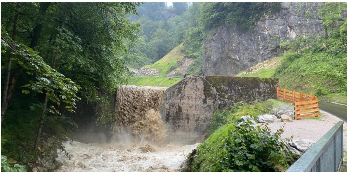
Abbildung 78: Kotbach hm 8,3 - Sortierwerk (Schlitzaufsatz auf einer Konsolidierungssperre). JAP 1982. Bauwerk zeigte beim Hochwasserereignis volle Wirksamkeit. Durch die Sperre konnte vor dem Stadtgebiet Schadgeschiebe retentiert werden.
