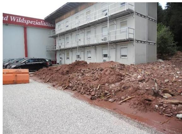
Abbildung 59: Foto 10 - Ablagerungen bis zu 1,5 m im Bereich der Gewerbezone
