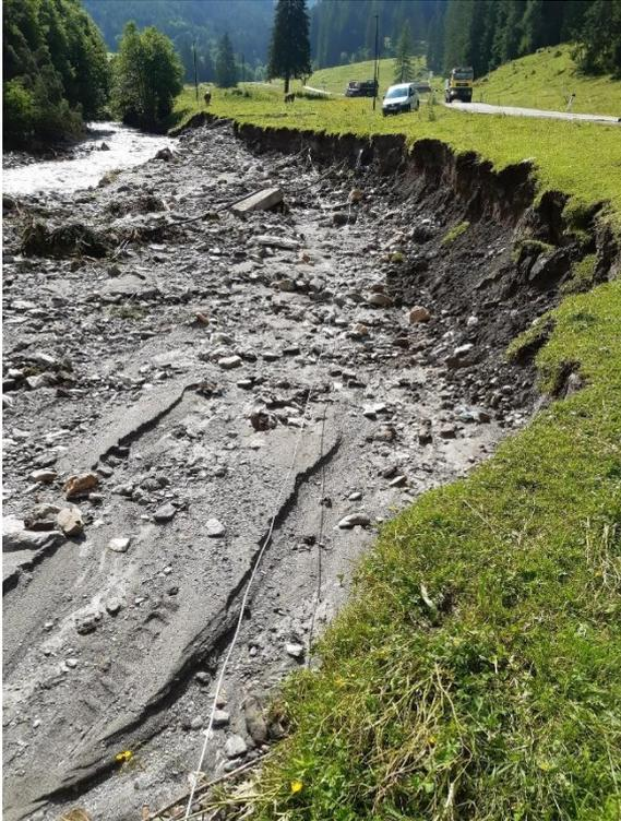
Abbildung 37: Massive Seitenerosion entlang der ungesicherten Bachstrecke
