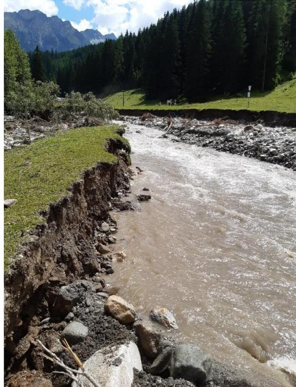
Abbildung 38: Massive Seitenerosion entlang der ungesicherten Bachstrecke
