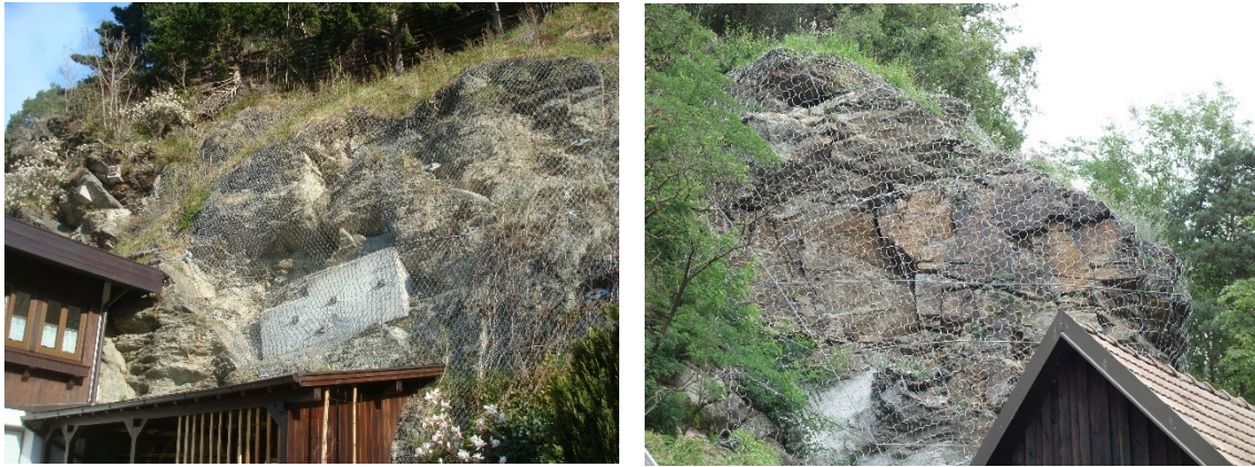
Abbildung 16: Technischer Steinschlagschutz (Felssicherung) konzipiert und gebaut durch die WLV
