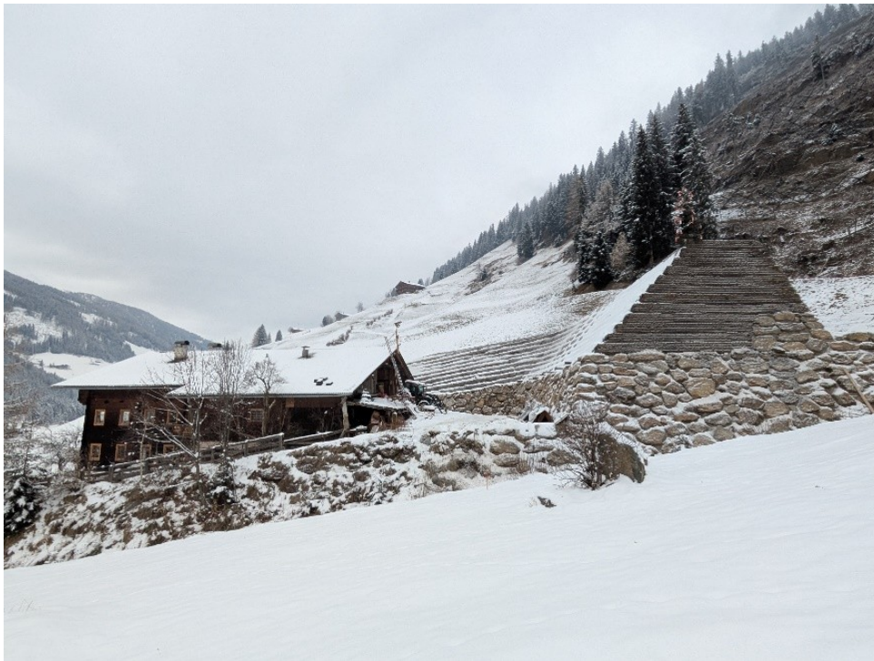
Abbildung 21: Steinschlagschutzdamm in Innervillgraten (Tirol)
