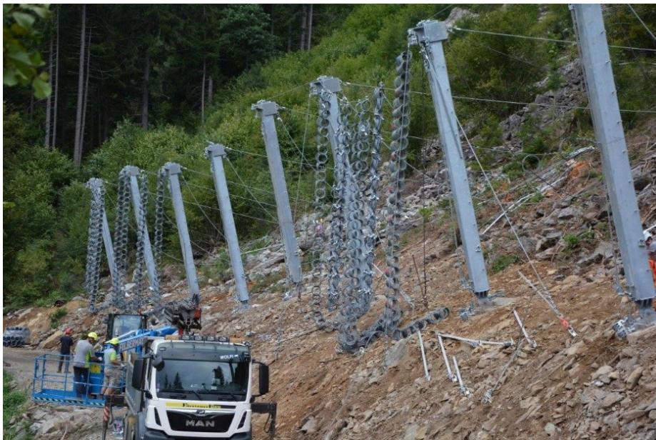
Abbildung 18: Errichtung eines Steinschlagschutznetzes durch die WLV
